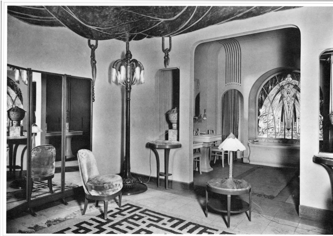
Figure 2-10 — H. & L. Barberis (architects), Salle de toilette.
