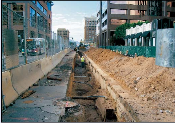
Light rail construction at Central Avenue and Adams Street Construcción del tranvía ligero en Central Avenue y Adams Street
