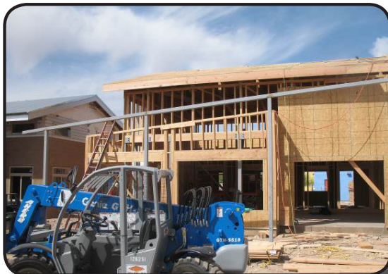
Las Abuelitas, Exterior Construction
