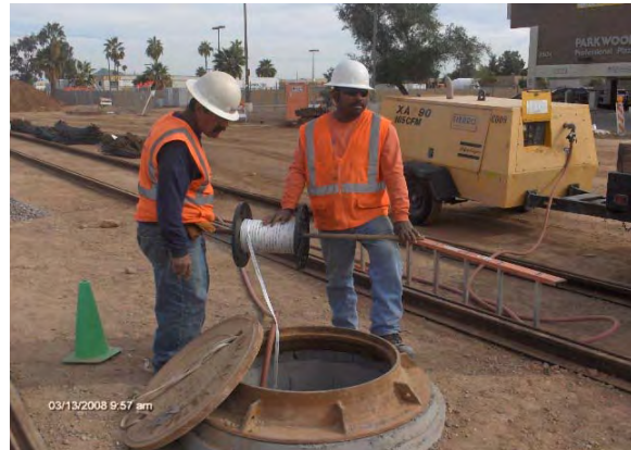
Fierro mandrelling ductbank conduits
