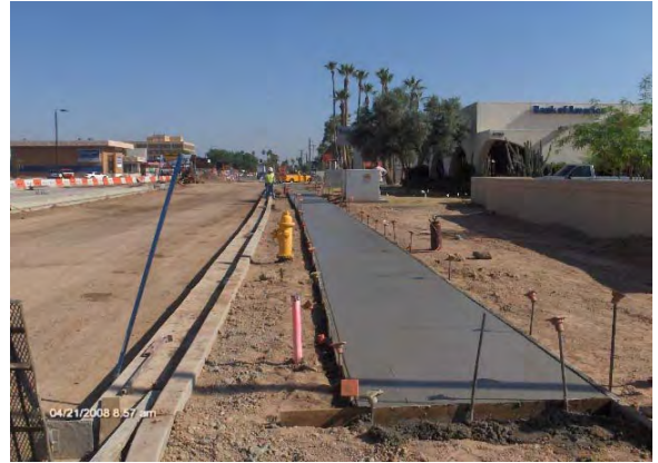
Pouring concrete sidewalk
